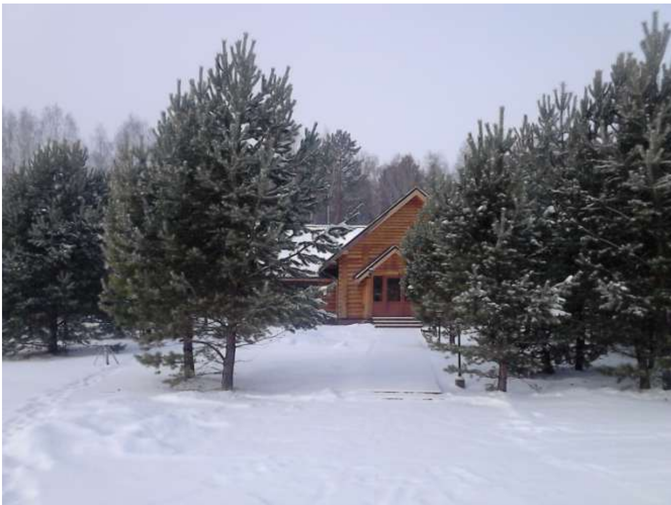
Фото 2 Существующий жилой дом
