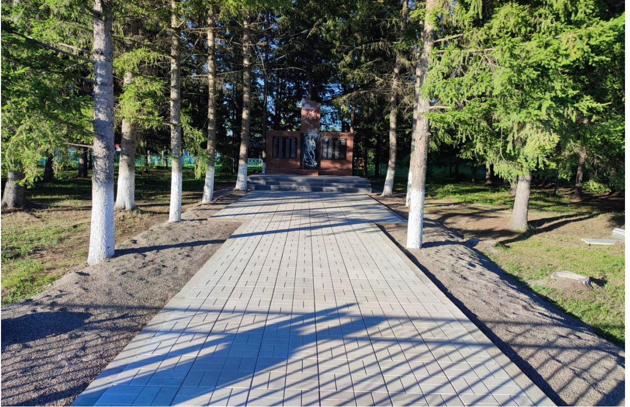
Памятник после ремонта
