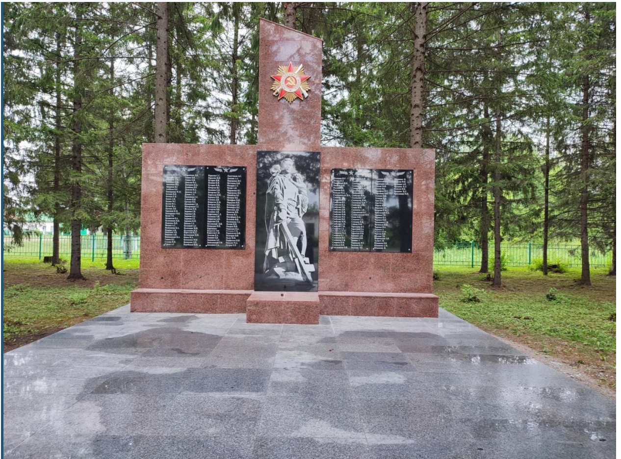
Памятник после ремонта
